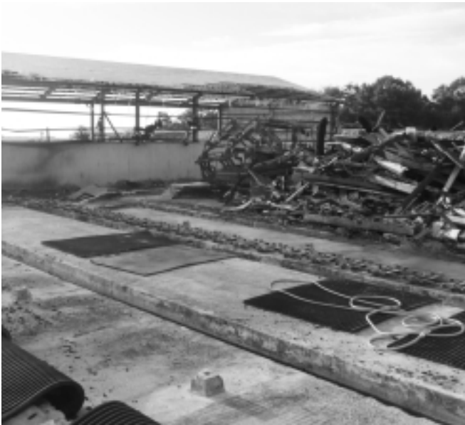
丸山地区牛舎火災現場
