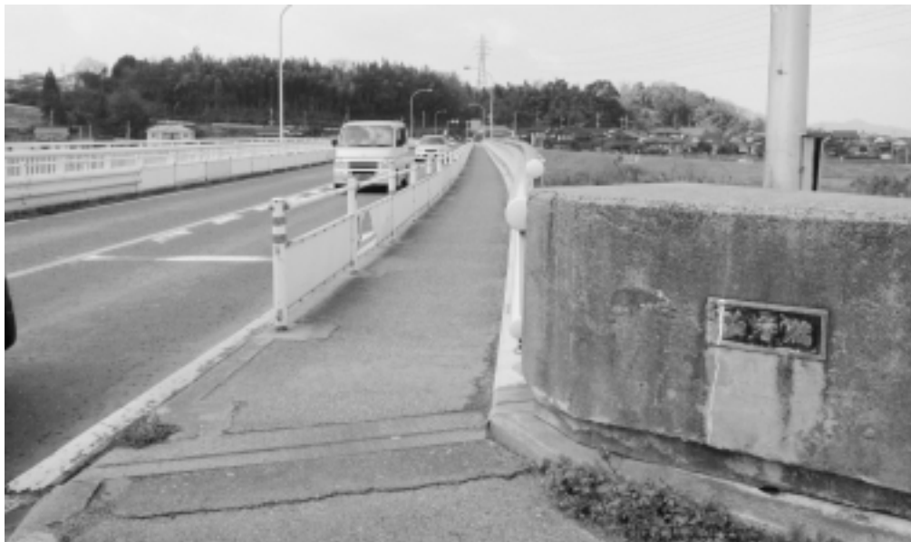
拡幅が予定される伯耆橋の歩道
