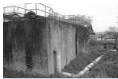
撤去予定のこしが浄化槽
