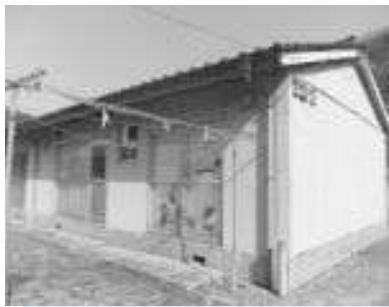
老朽化した町営住宅
