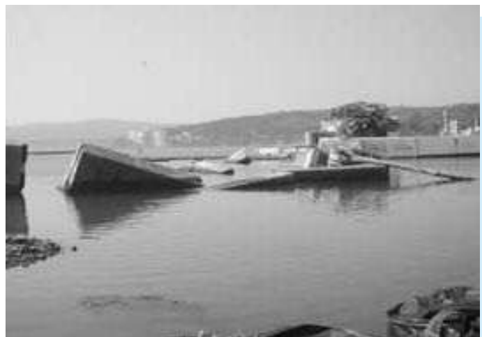
大津波に粉碎された5mの防潮堤
