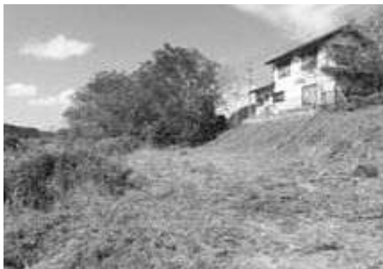
未整備の日野川石岸(上細見地区)
