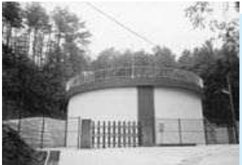
水道水源施設配水池 (坂長地内)
