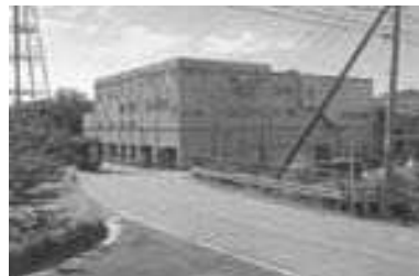
基盤改修されるリサイクルプラザ（岸本地内）
