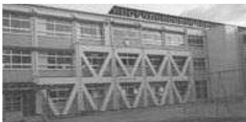
耐震強化された校舎（岸本小学校）
