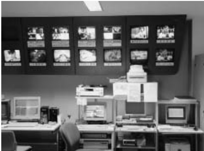
有線テレビジョン調整室
