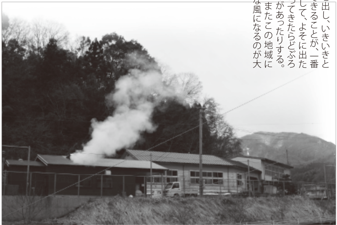
二部小学校福岡分校のグラウンドの一部に建っている「株式会社 上代」の事務所及び醸造所
