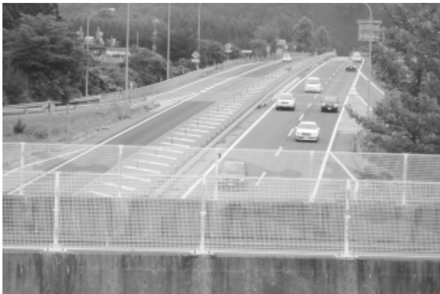
早期四車線化が望まれる米子自動車道
