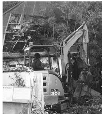
解体が進む特定空き家
