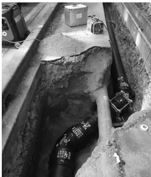
水道老朽管の更新の様子
