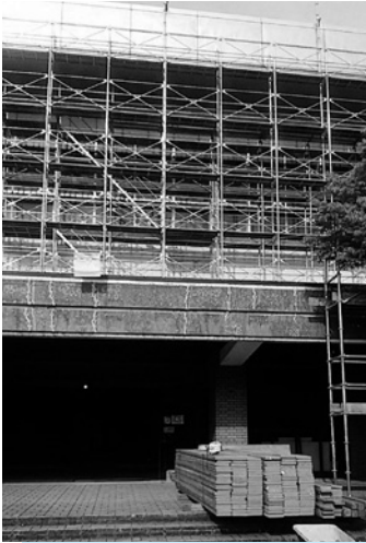
大規模改修中の溝口体育館
