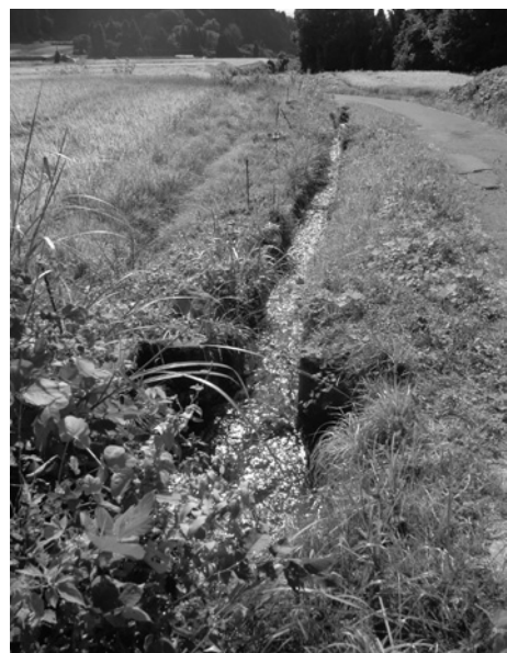
枋原地内水路改修予定地
