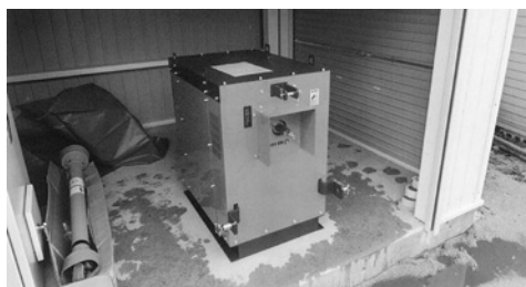
二部小に設置されているトラクター発電機
