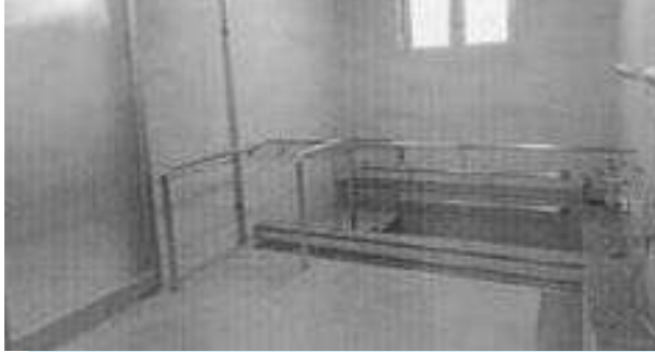
改修中の浴室（岸本老人福祉センター）
