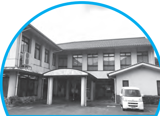
溝口福祉センター 改修
