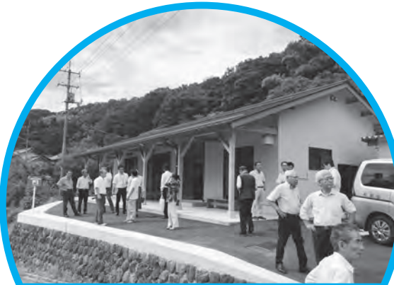
根雨原公民館の 新設
