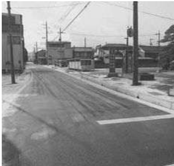
拡幅改良など整備された岸本公民館前
