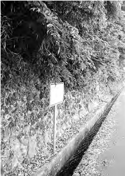
急傾斜地崩壊危険箇所「大寺地区」
