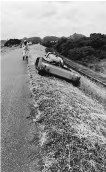
日野川堤防を守る除草作業 (日野川左岸下流部)
