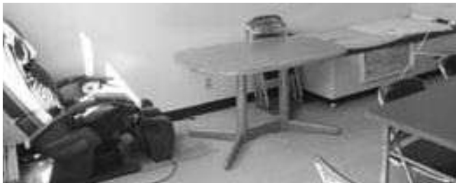
改修予定の会議室
