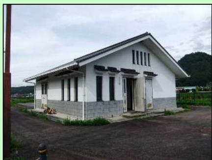
旭地区処理施設の建屋
