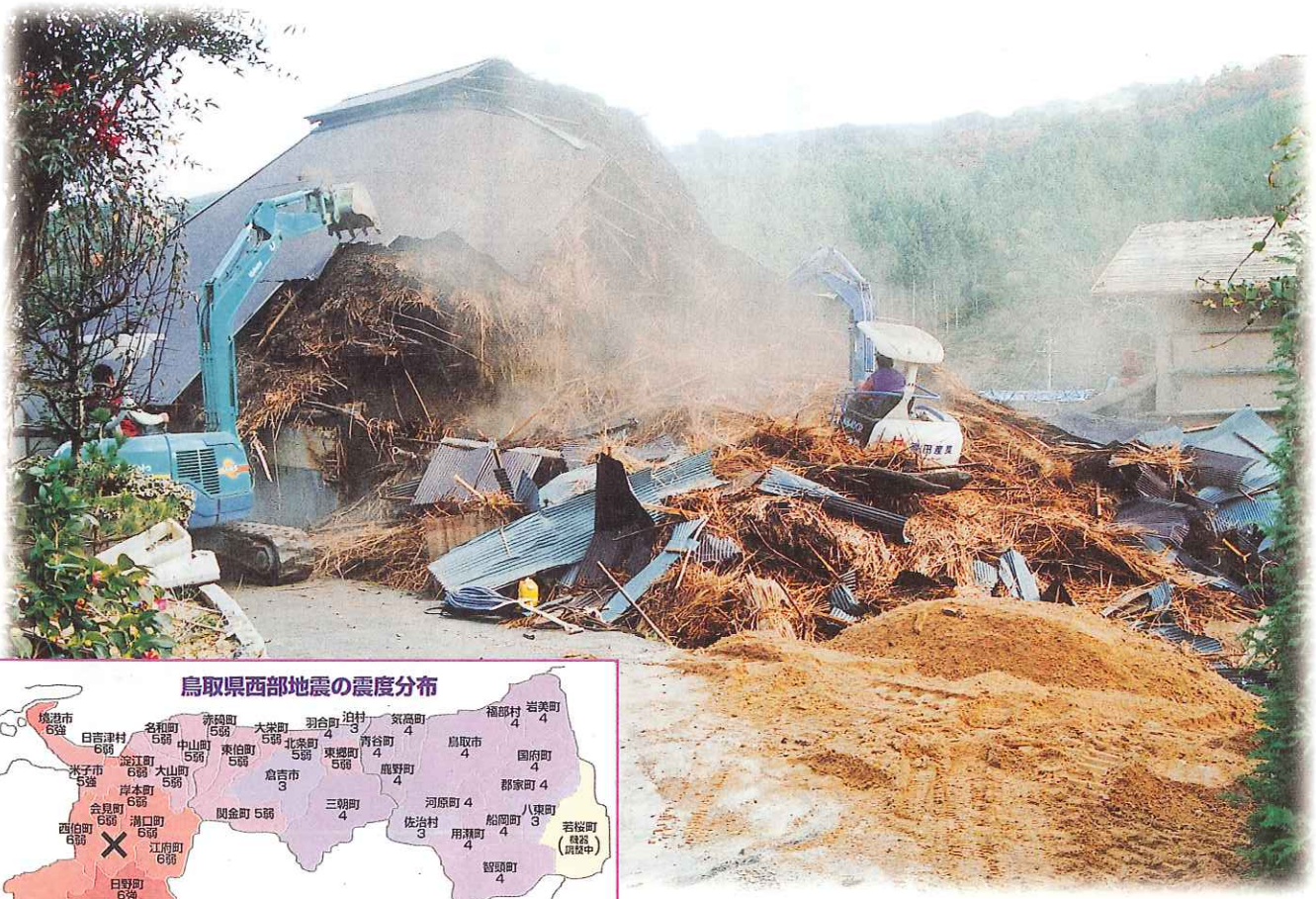
●被害家屋の撤去作業 福岡地内
