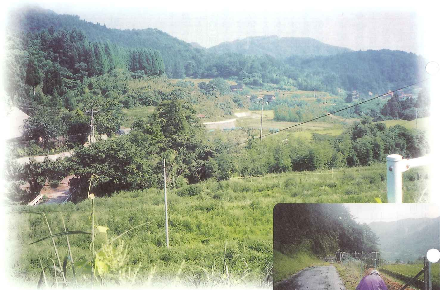
●草ぼうぼうの休耕田と猪の共同防護柵設置作業 福岡地内
