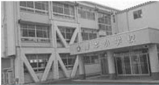
改装された岸本小学校（児童玄関、耐震補強、渡り廊下）
