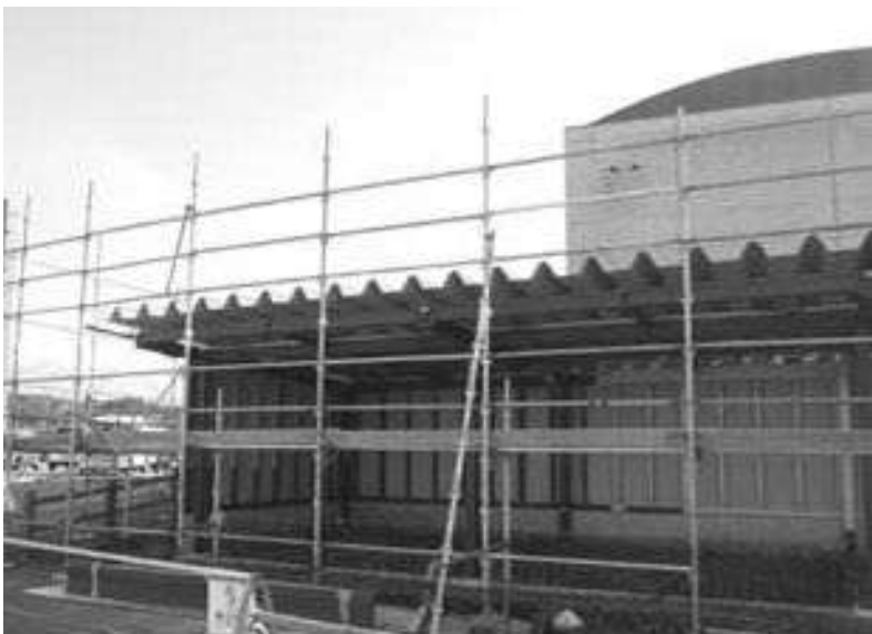
非常時の備え（伯耆町防災車庫＝建築中）
