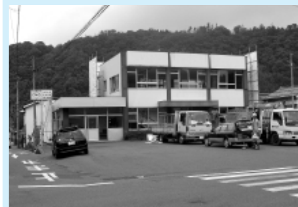
解体される商工会館
