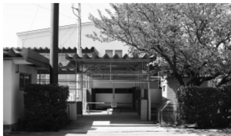
立ち入り禁止になっている岸本小学校体育館
