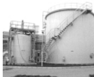
メタン発酵槽（中温湿式）
