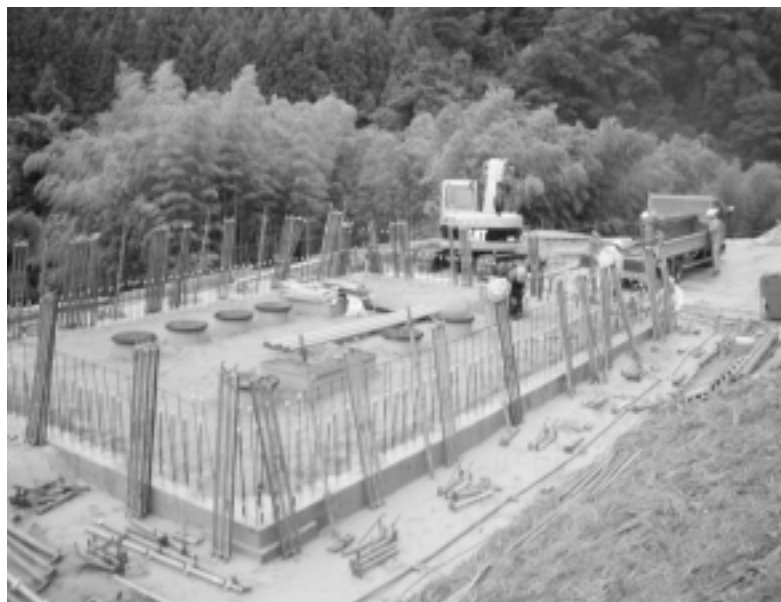
大滝地区農業集落排水施設
