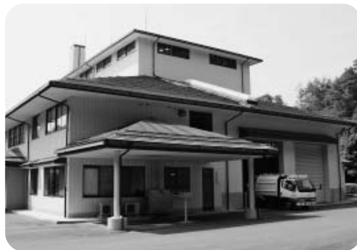
南部町・伯耆町清掃施設管理組合クリーンセンター
