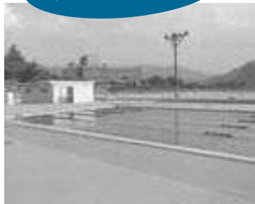
50mコース→25mコースに改修 (溝口中学校プール)
