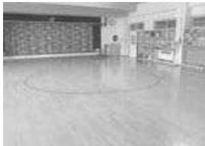
床暖房設置の溝口保育所
