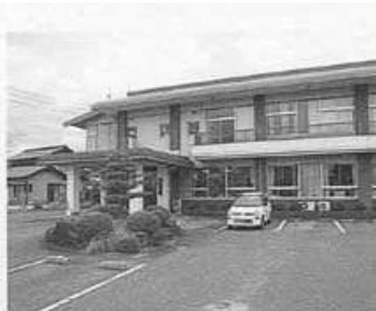
岸本老人福祉センター(改築工事着手H26年夏頃見込み)
