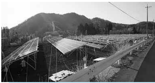
太陽光整備が進む宮原発電所
