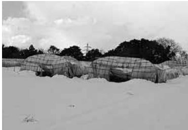
大雪によるビニールハウス倒壊
