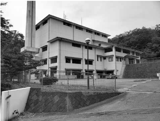
南部町・伯耆町清掃施設管理組合 クリーンセンター
