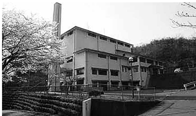
移設予定の可燃物処理場(南部町)
