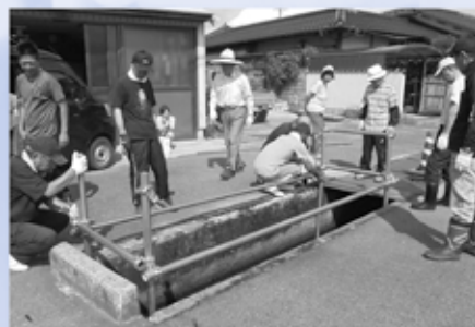
転落予防の柵を設置しました
