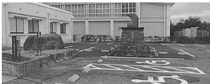
前庭もスッキリした岸本町民体育館（改修完了）
