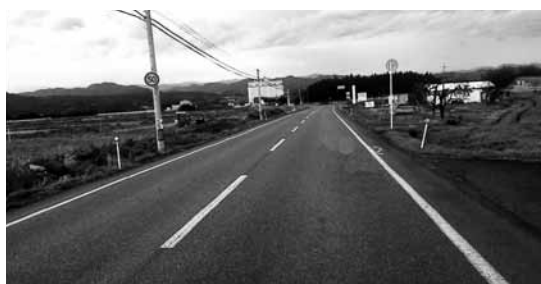
町道岸本大原線改良事業
