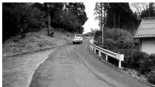
町道藍野真野線改良事業
