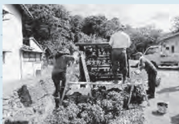
出雲街道道標の補修整備
