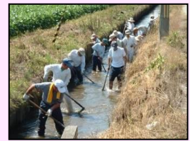
水路の泥上げ
