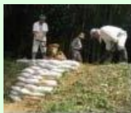
漏水箇所の補修
