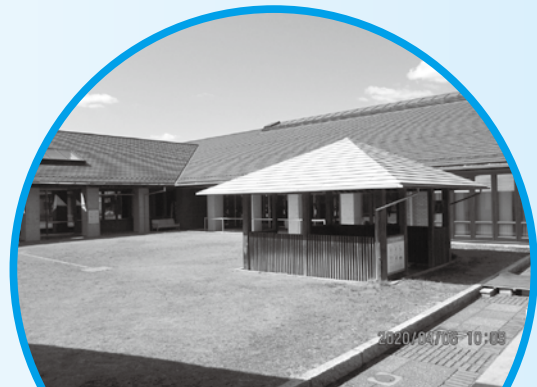
岸本福祉センター 福祉棟空調改修事業 1億1,660万円
