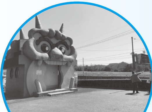
溝口インター情報発信施設整備事業 (鬼トイレの改修工事着工) 960万円
