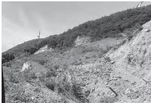
能登半島地震の風力発電被災地
