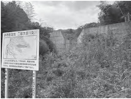
二部大谷川砂防堰堤
