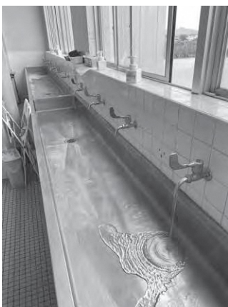
岸本中学校の手洗い場
