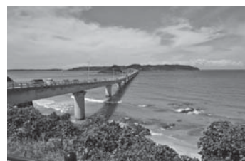
本土側から角島大橋と角島を望む
