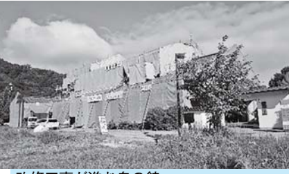
改修工事が進む鬼の館
