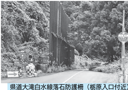
県道大滝白水線落石防護柵 (栃原入口付近)
